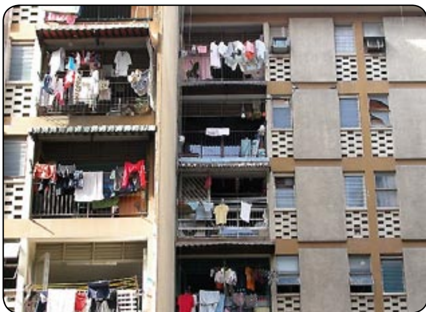
L'urbanisme des années 60 sera bientôt un mauvais souvenir.
